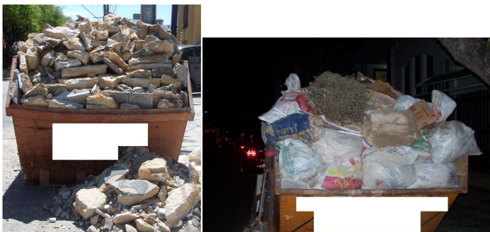
Figuras 2 e 3: Caçamba Estacionária em via pública com acondicionamento inadequado.
