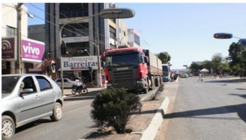
Figura 06 – BR – 242 no trecho que corresponde a Av. Benedita Silveira, junho de 2010. Fonte: Autores.
