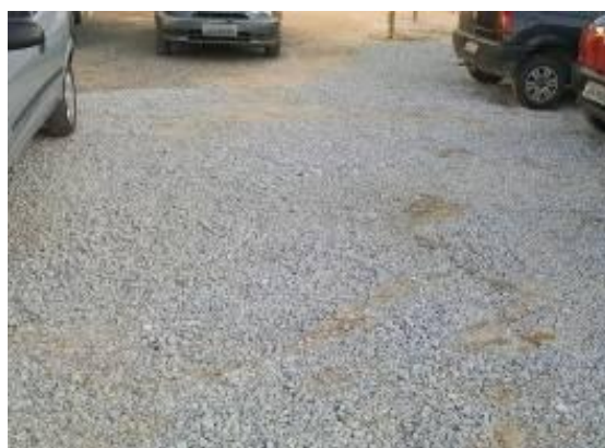
Figura 7 - Regularização de vias de acesso
